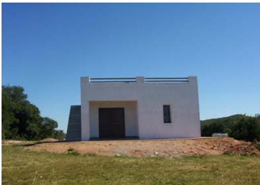
Figura 5 a) Centro de control del Observatorio de Aiguá (en construcción).
