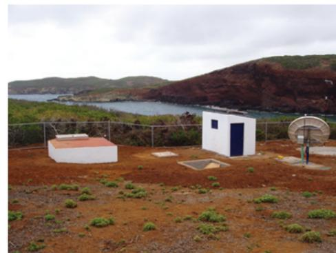
Figura 4. Estación sísmica de Playa Norte. El edificio de la izquierda alberga los sismómetros. En la caseta de la derecha se guarda equipo eléctrico. En el extremo derecho se ve la antena que transmite los datos.
