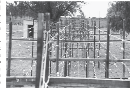
Fig. 1. Un acercamiento a los dipolos que forman la antena del Observatorio de Centelleo Interplanetario (MEXART) en Coeneo, Michoacán.
