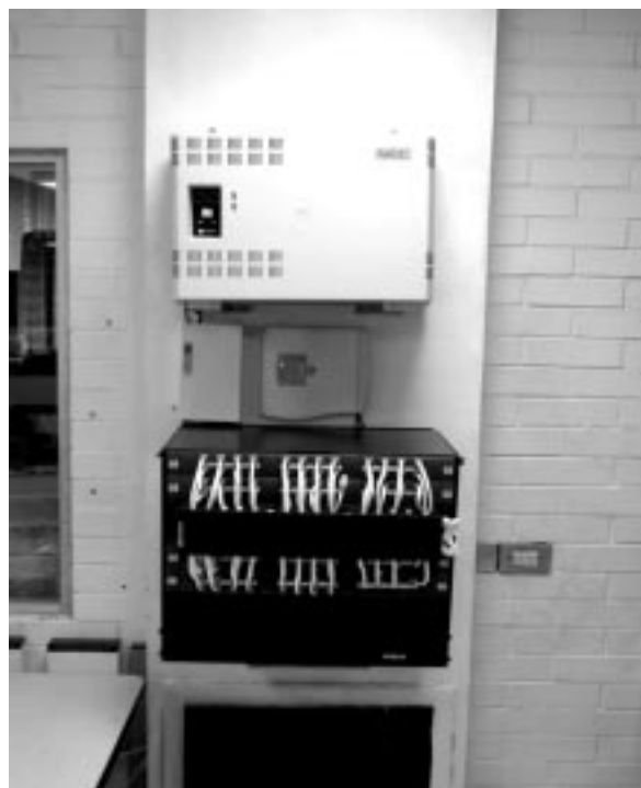
Conmutador nec 26-64 con correo de voz y rack de distribución.
