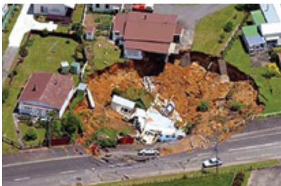
Subsidencia del terreno en una zona urbana
