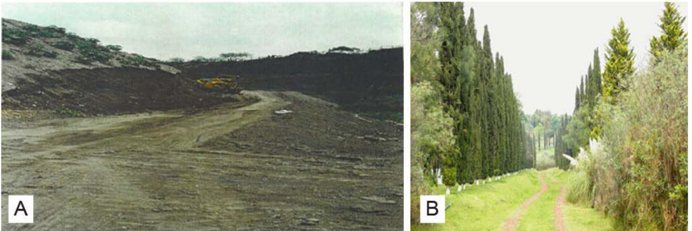
Figura 18. A. Movimiento del material depositado en la cantera para estabilizar el talud formando terrazas para su posterior revegetación y delineando el camino de acceso que se construyó posteriormente. Cortesía de Francisco Martínez, 1997. B. Árboles exóticos que se plantaron a lo largo del camino. Cortesía de Manuel Figueroa Maheng, 2006.
